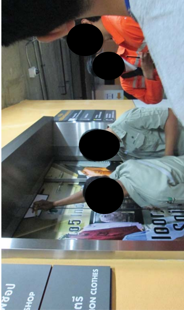
ฝ่ายวิศวกรรม - ทีมช่างไปที่จุดเกิดเหตุ และใช้เบรกลิฟต์เพื่อตรวจสอบว่าลิฟต์จอดตรงชั้นหรือไม่
